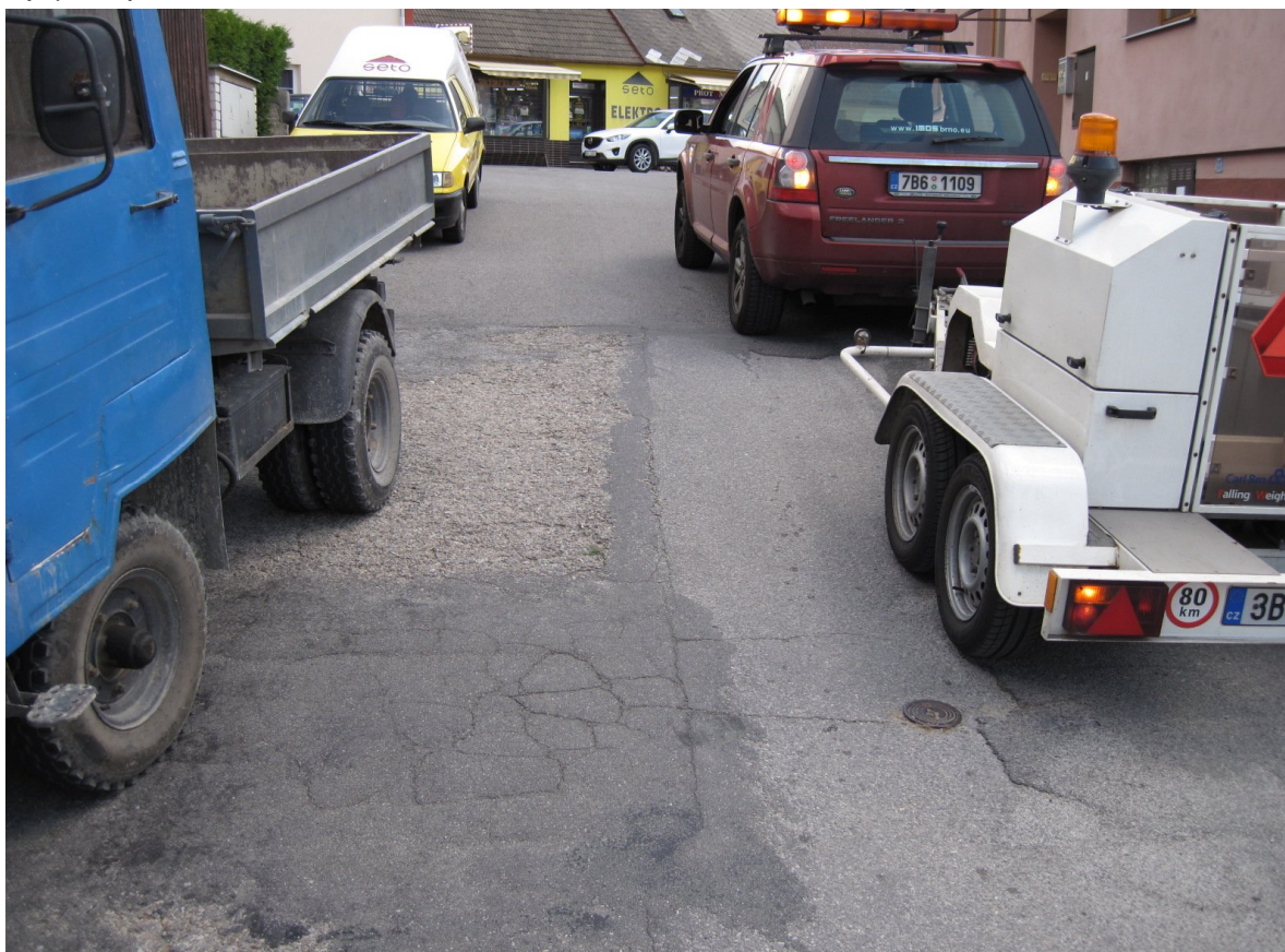
F06, km 0,422+ Konec úseku, síťové trhliny, vysprávký
