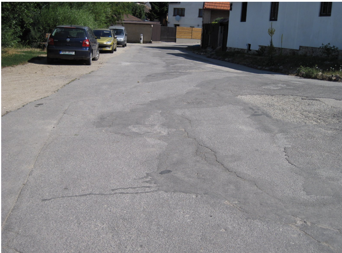
F04, km 0,315+ Vysrávky, deformace, hloubková koroze
